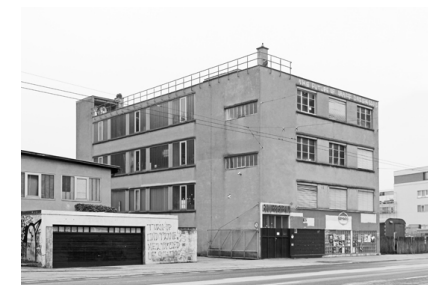
West- und Südseite. 2017
