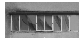
Originale Fenster der Toiletten- und Garderoben. 2017
