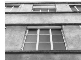
Die veränderte Ostfassade. 2017
