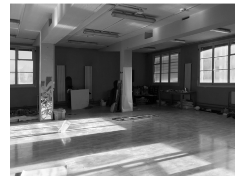
Die Tragjoche hinten sichtbar die sich verjüngende Auskragung. 2017
