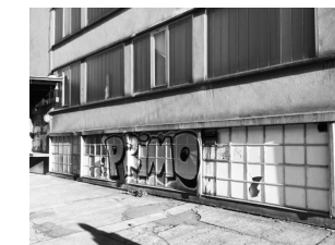
Westfassade, oben neuere Profilit-Verglasung, unten originale Metallfenster. 2017
